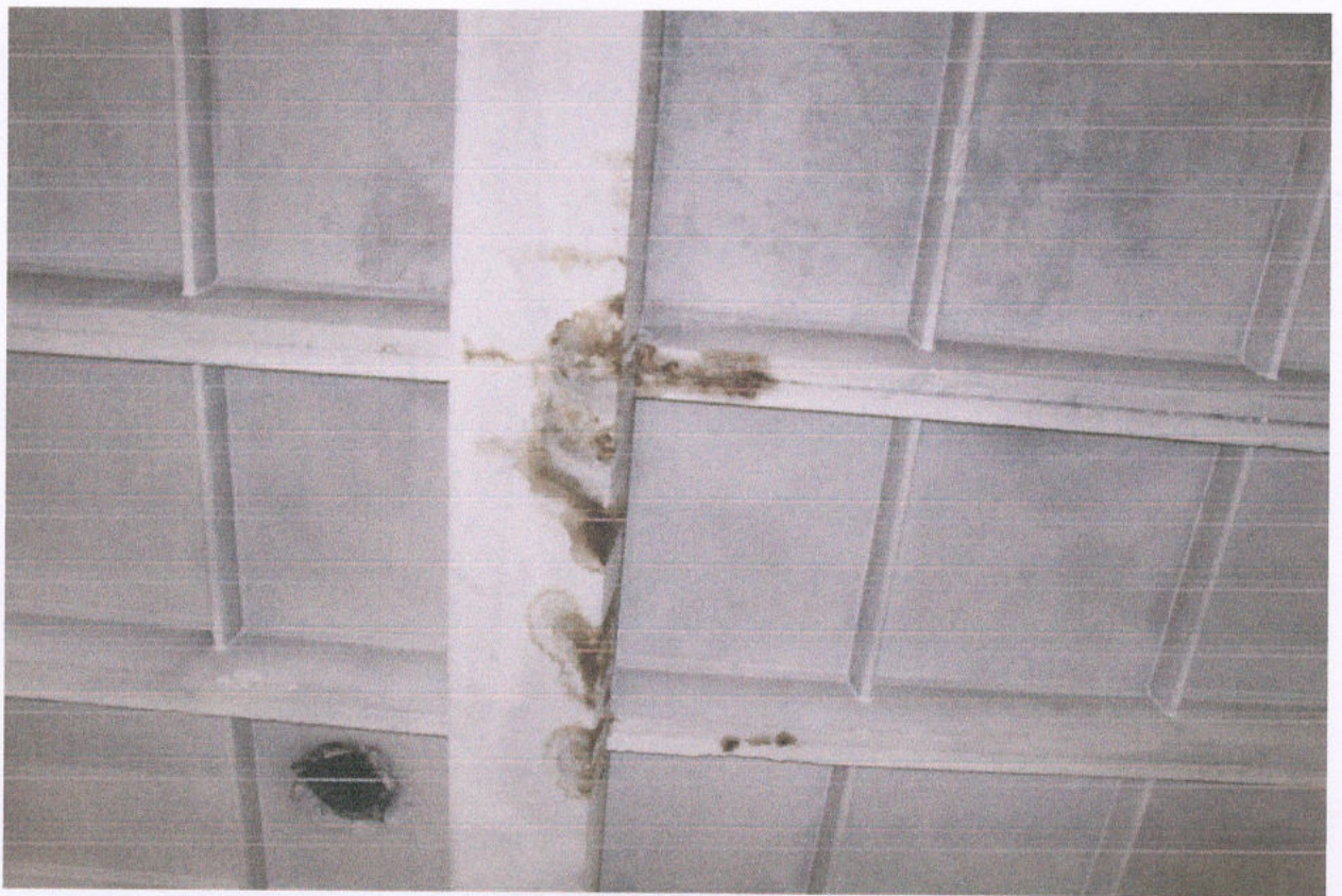
Фото 15. Следы залития с кровли
