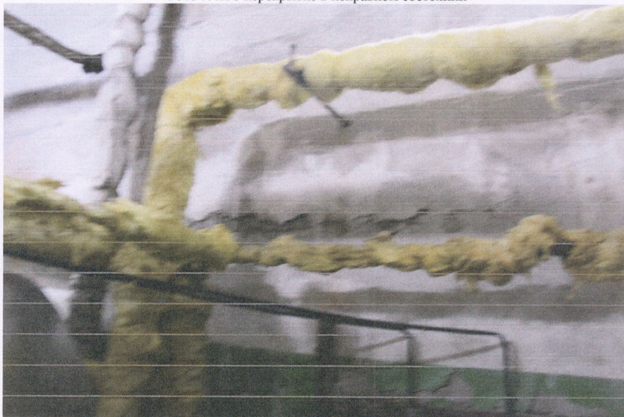
Фото 6. Промокшая и промороженная наружная восточная стена, соприкасающаяся с грунтом
