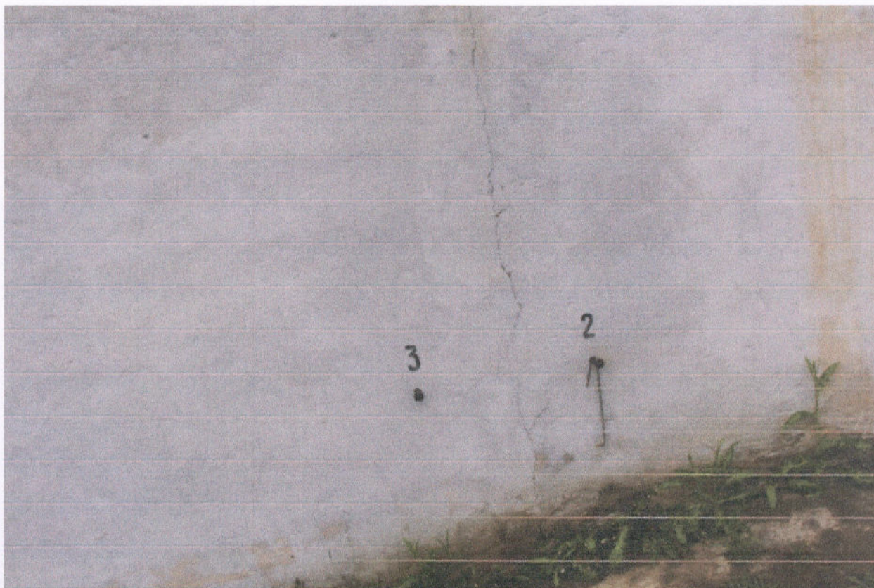
Фото 20. Вертикальная историческая трещина в стыке пристроек
