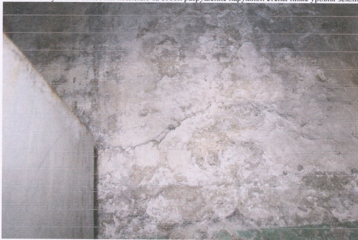
Фото 12. . Промокшая и промороженная наружная восточная стена, соприкасающаяся с грунтом
