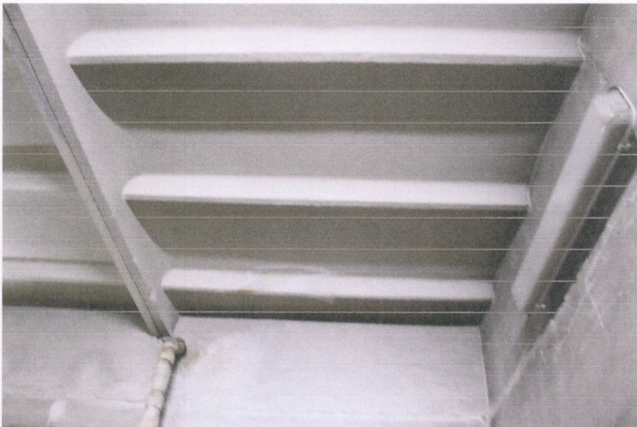
Фото 5. Ж/б перекрытие в исправном состоянии
