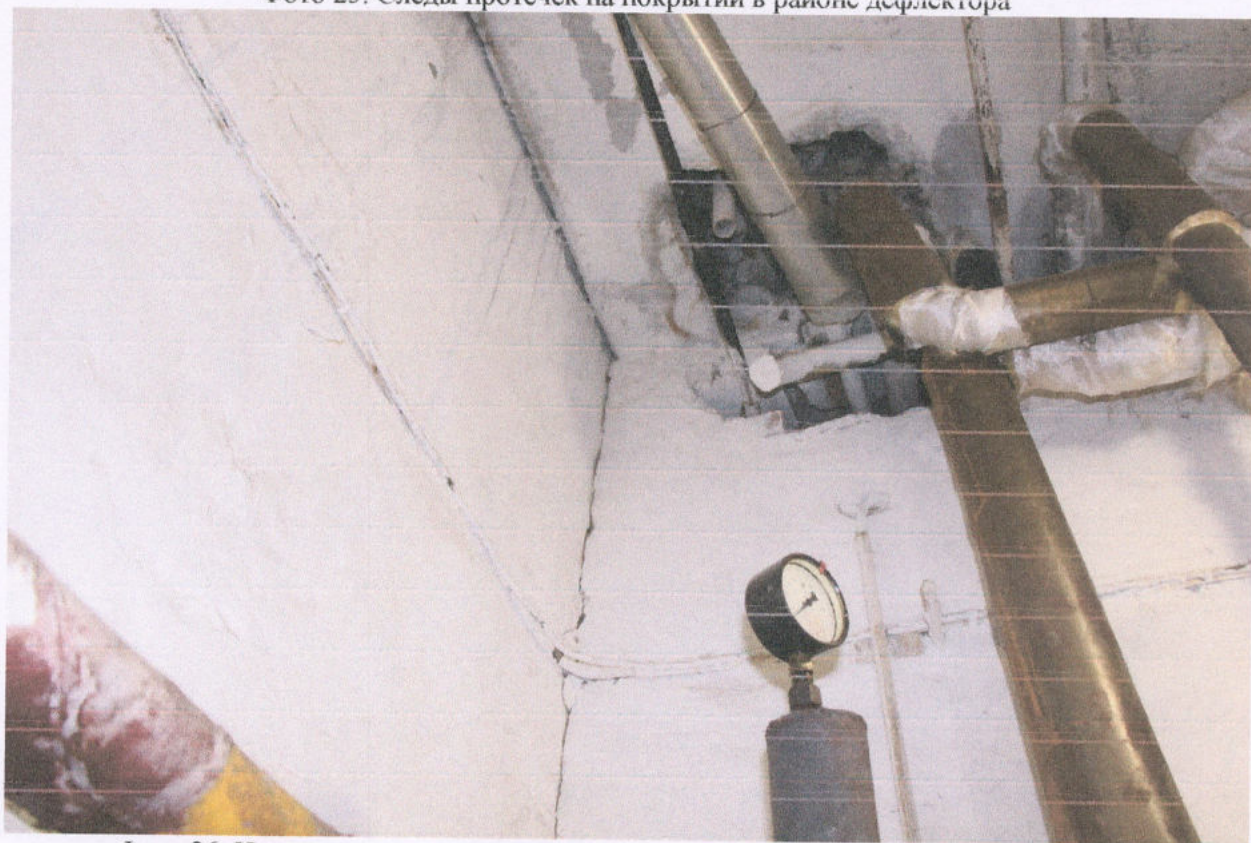
Фото 26. Историческая трещина в примыкании перегородки к наружной стене
