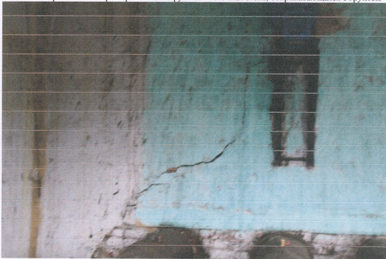
Фото 28. Наклонная историческая трещина без следов развития из-за просадки фундаментов
