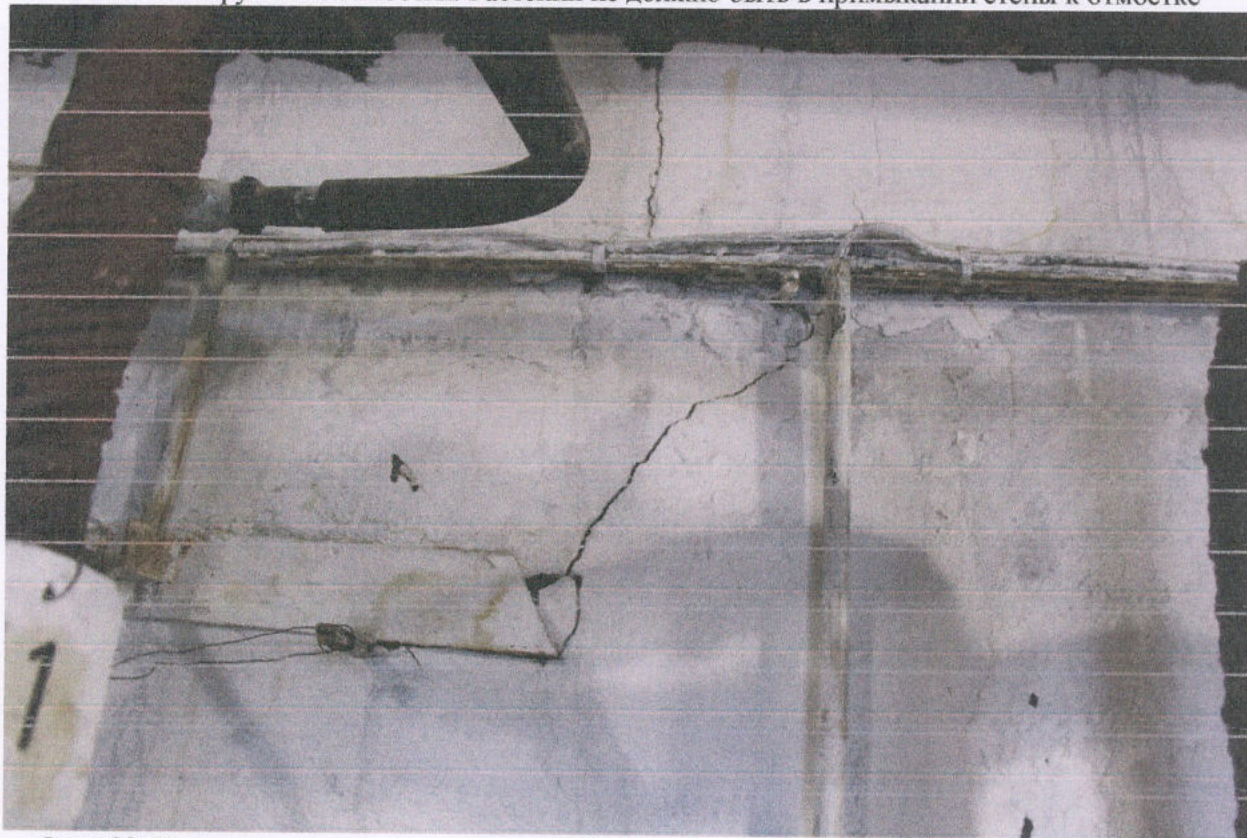
Фото 22. Наклонная историческая трещина без следов развития из-за просадки фундаментов
