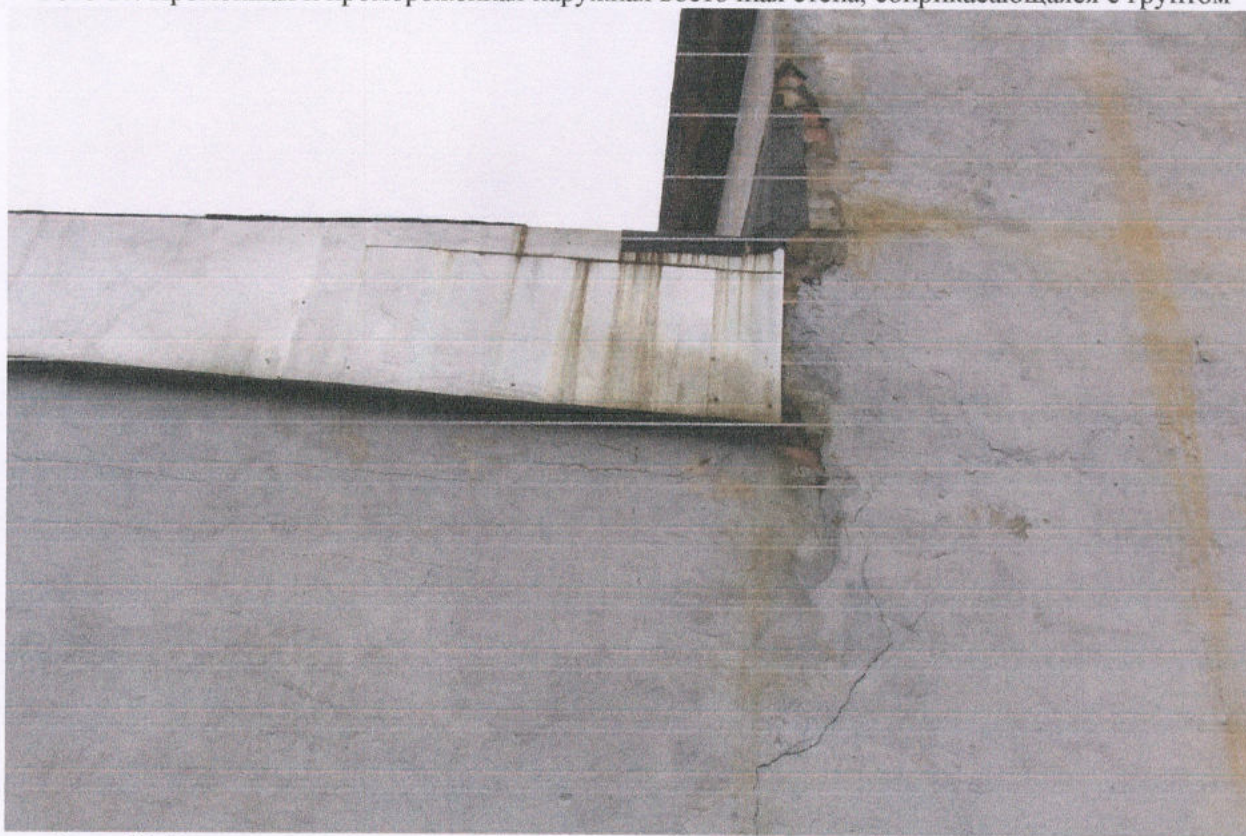
Фото 19. Вертикальная историческая трещина на наружной стене из-за посадки фундамента
