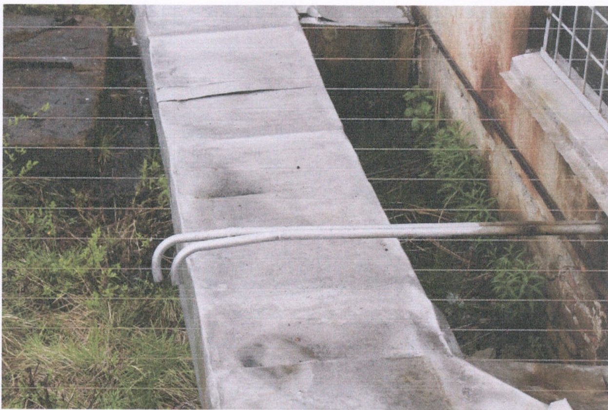
Фото 11. Отсутствие отмостки повлекло за собой разрушение наружной стены ниже уровня земли
