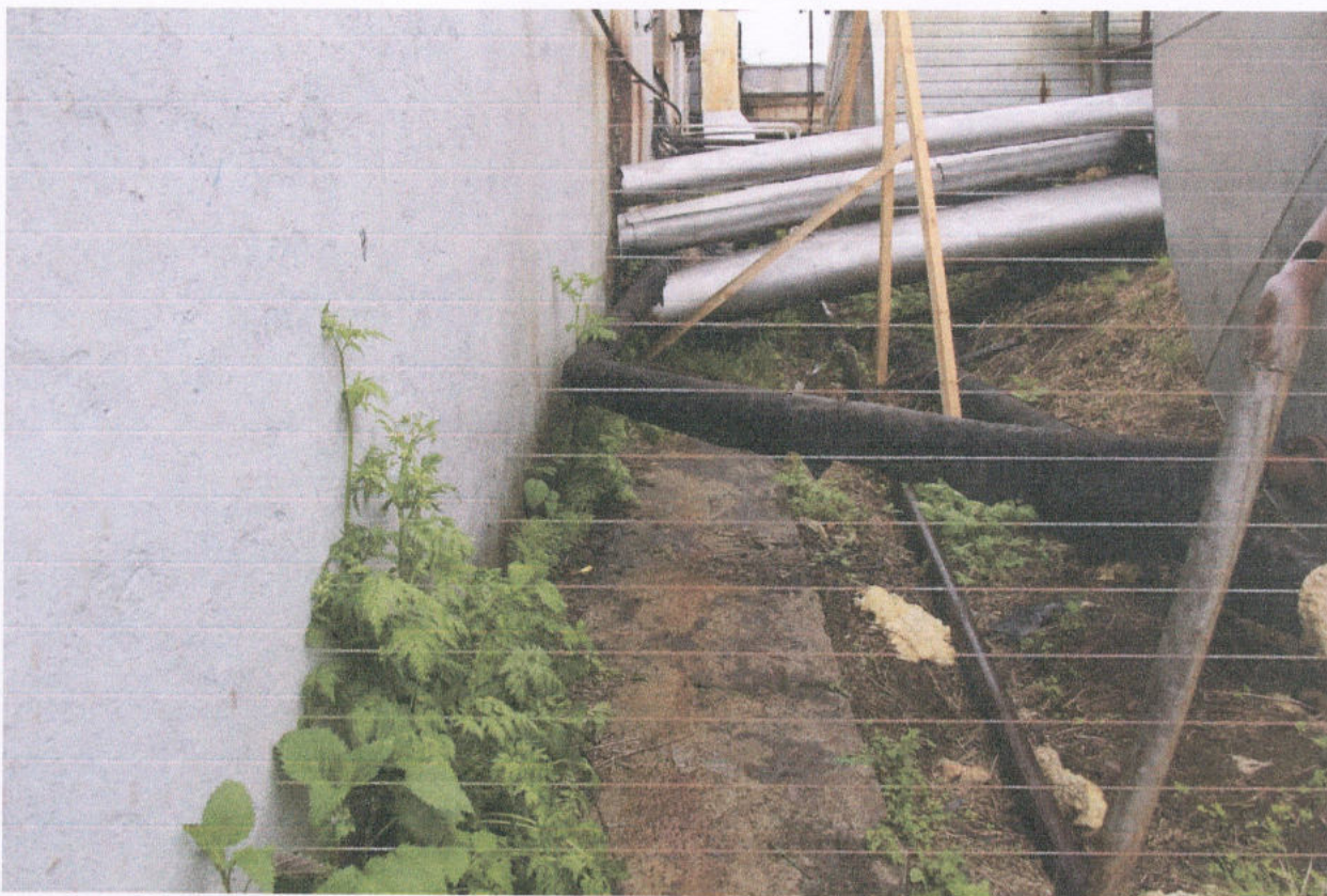
Фото 22. Разрушение отмостки. Растений не должно быть в примыкании стены к отмостке
