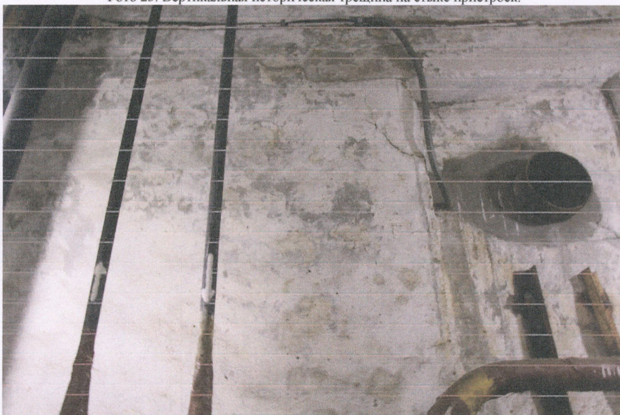
Фото 24. Промокшая и промороженная наружная восточная стена, соприкасающаяся с грунтом
