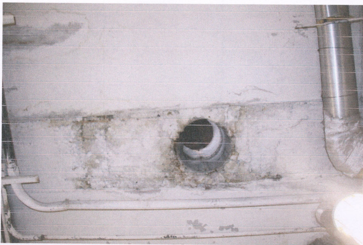
Фото 25. Следы протечек на покрытии в районе дефлектора
