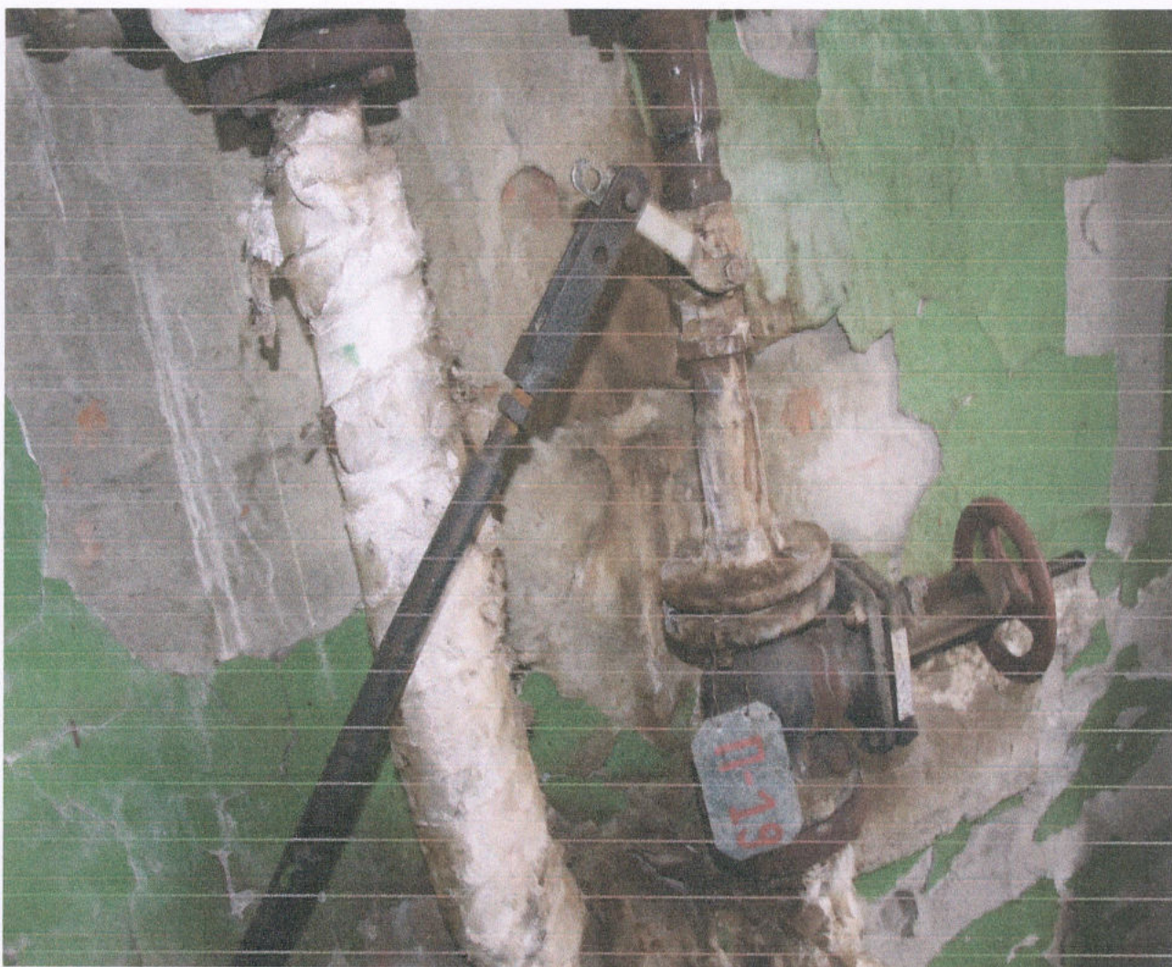
Фото 9. Промокшая и промороженная наружная восточная стена, соприкасающаяся с грунтом
