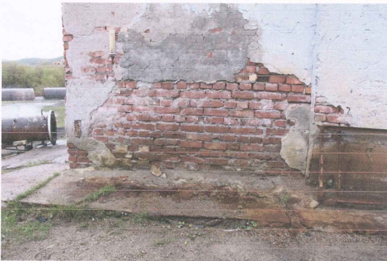
Фото 29. Обрушение штукатурного слоя на стене пристройки. Разрушение отмостки.
