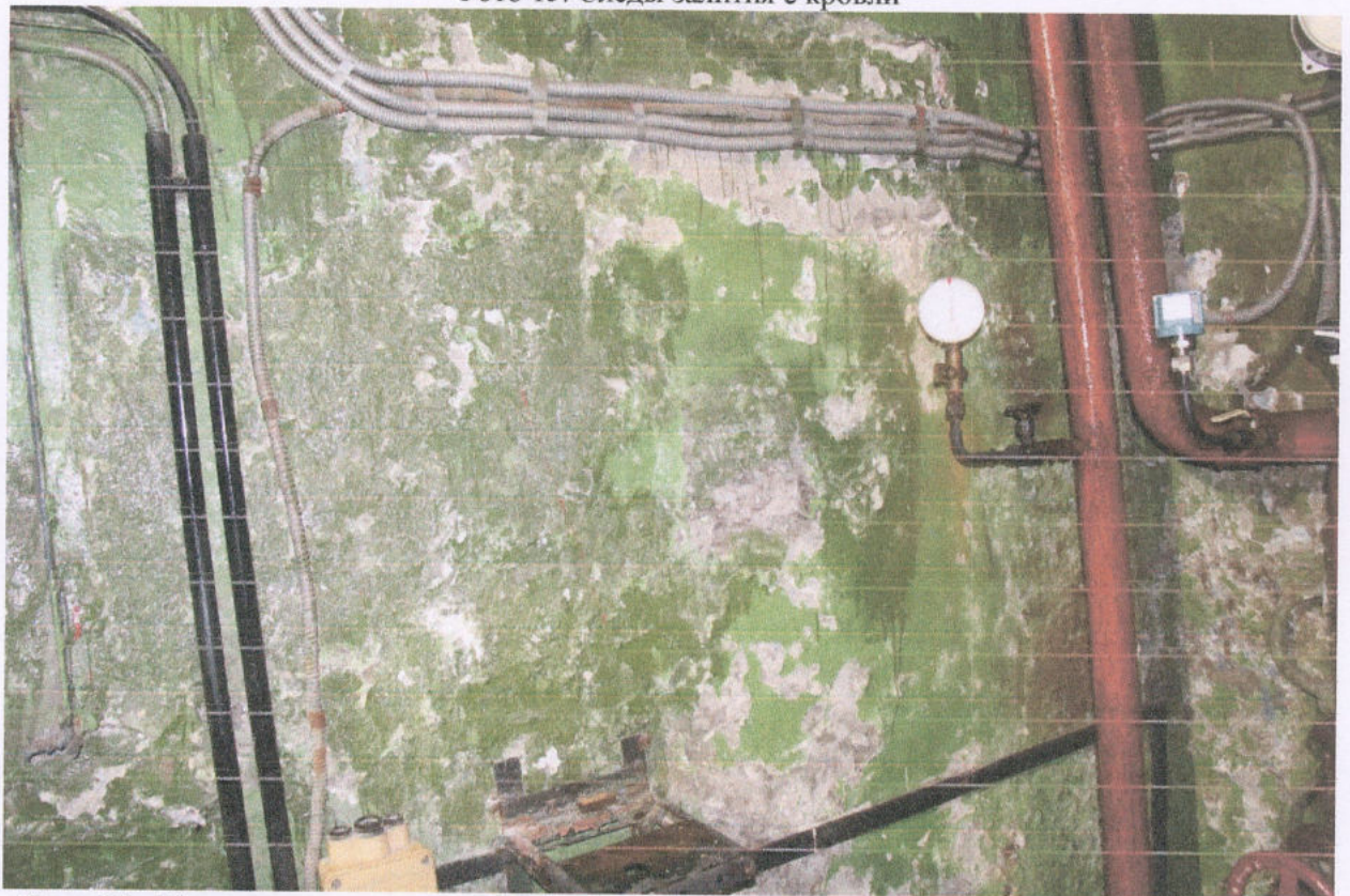
Фото 17. . Промокшая и промороженная наружная восточная стена, соприкасающаяся с грунтом
