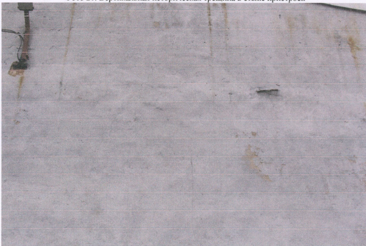
Фото 21. Волосная историческая трещина на наружной стене
