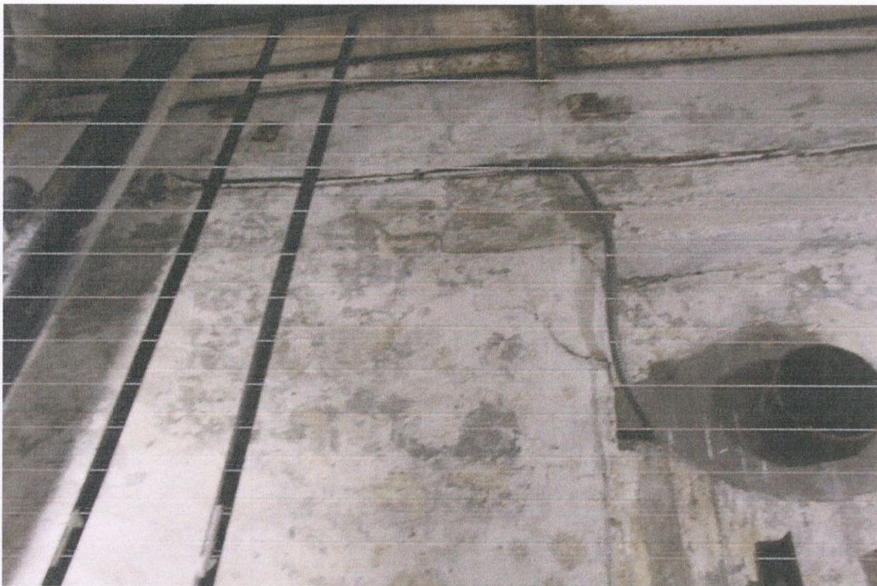
Фото 27. Промокшая и промороженная наружная восточная стена, соприкасающаяся с грунтом
