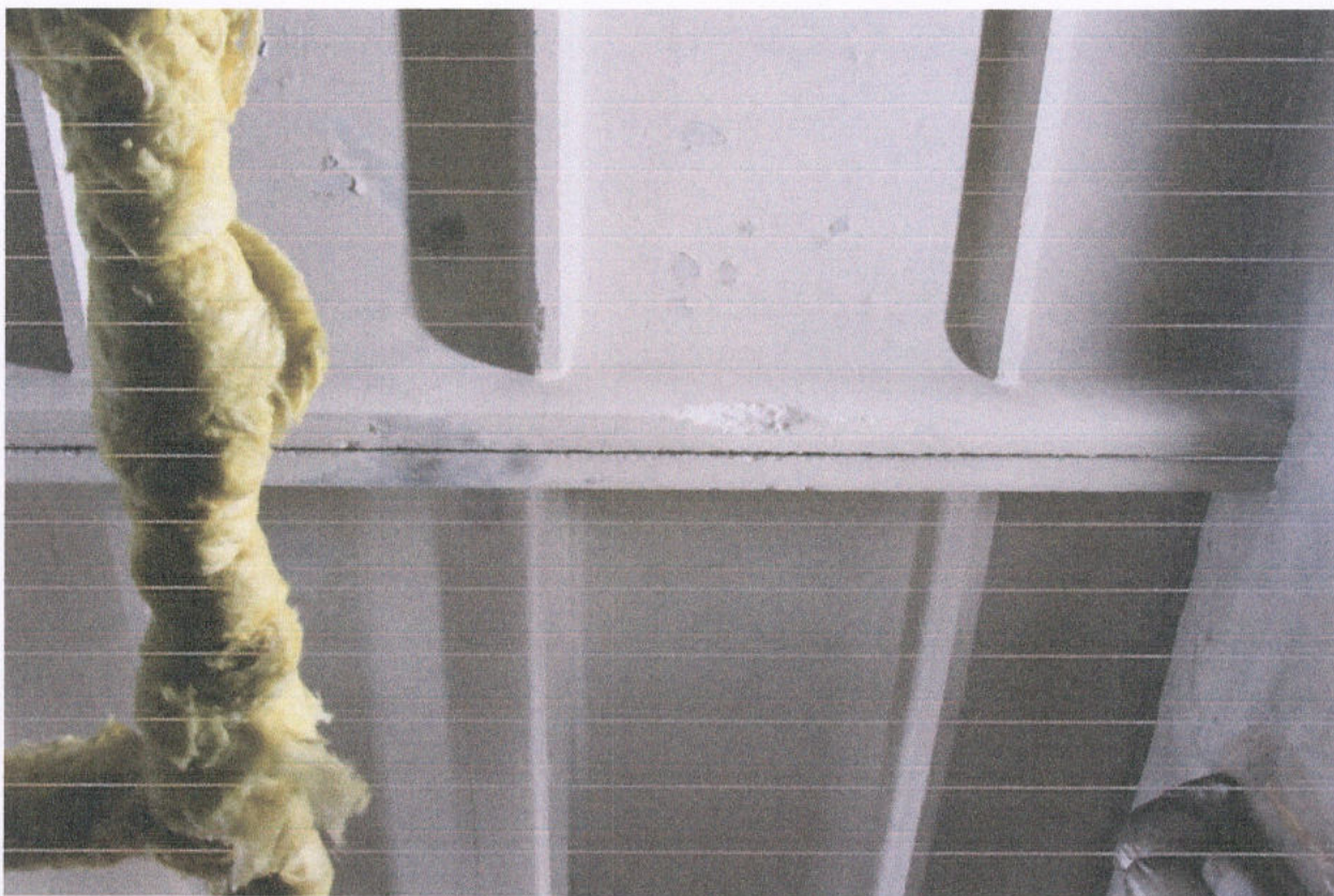
Фото 7. Незначительный скол на ребре плиты перекрытия
