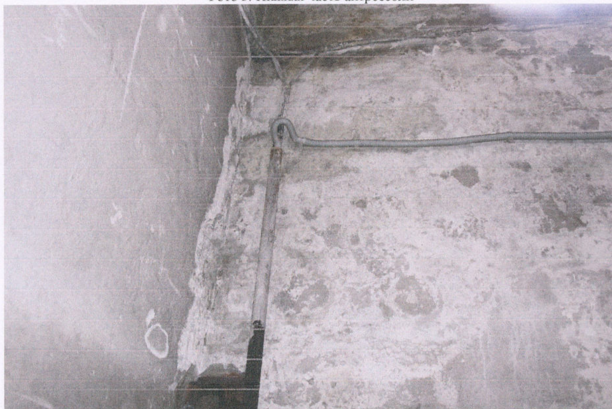
Фото 4. Промокшая и промороженная наружная восточная стена, соприкасающаяся с грунтом
