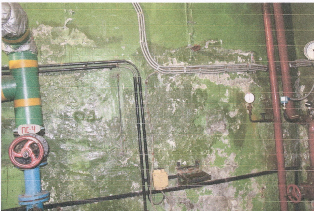
Фото 18. Промокшая и промороженная наружная восточная стена, соприкасающаяся с грунтом
