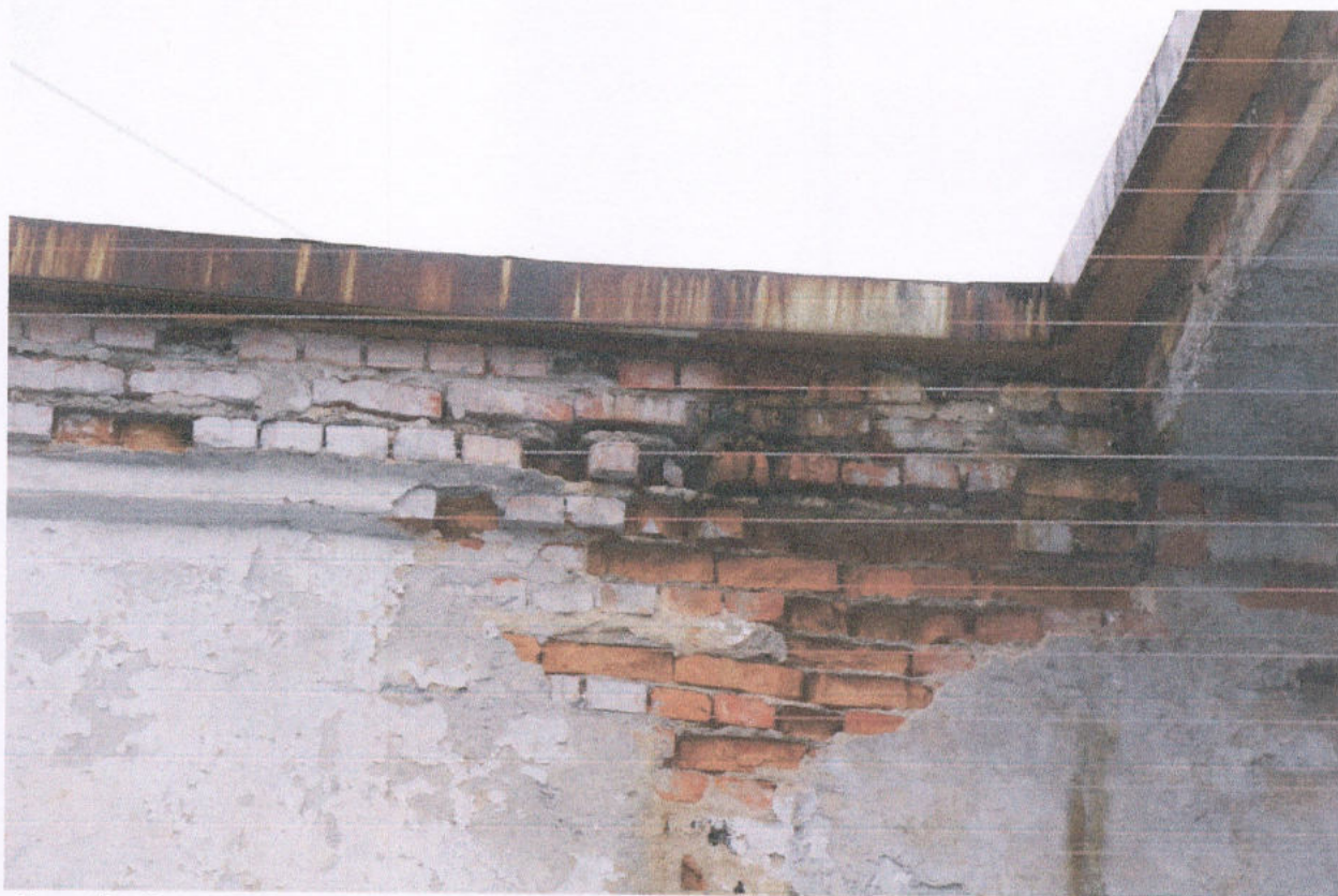
Фото 31. Разрушение штукатурного слоя и кирпичной кладки пристройки из-за неисправной ранее кровли.
