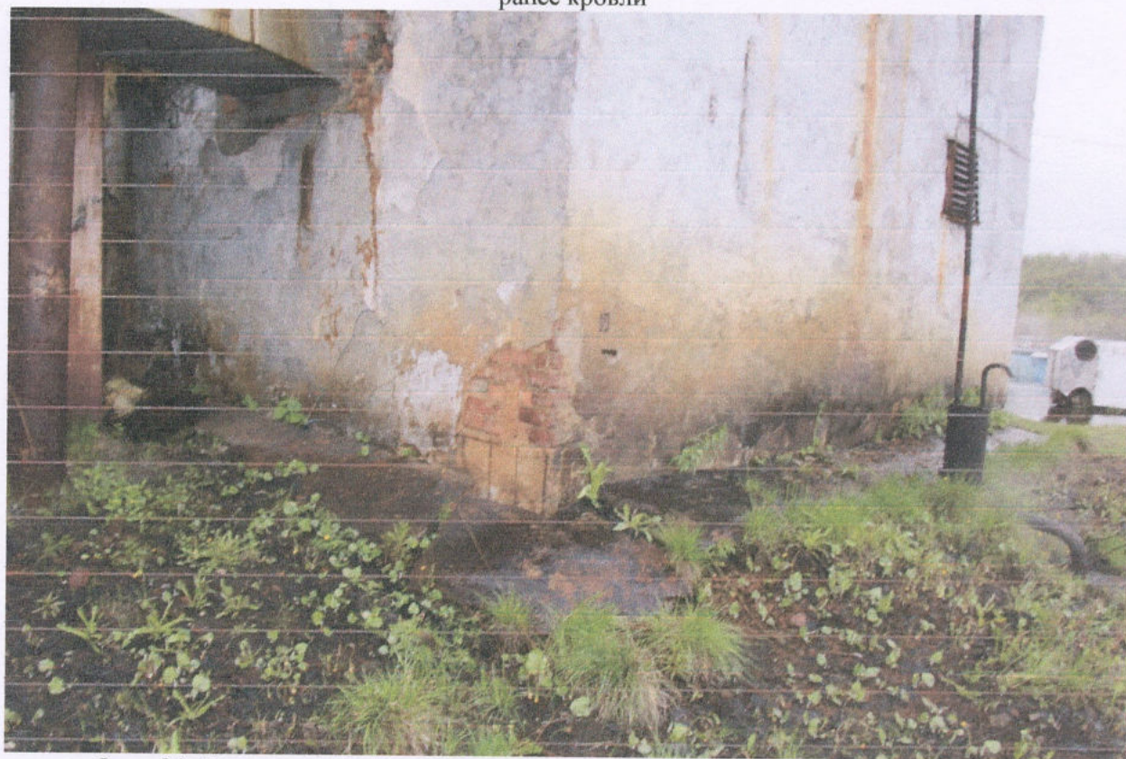
Фото 34. Разрушение штукатурного слоя и кирпичной кладки пристройки и цоколя
