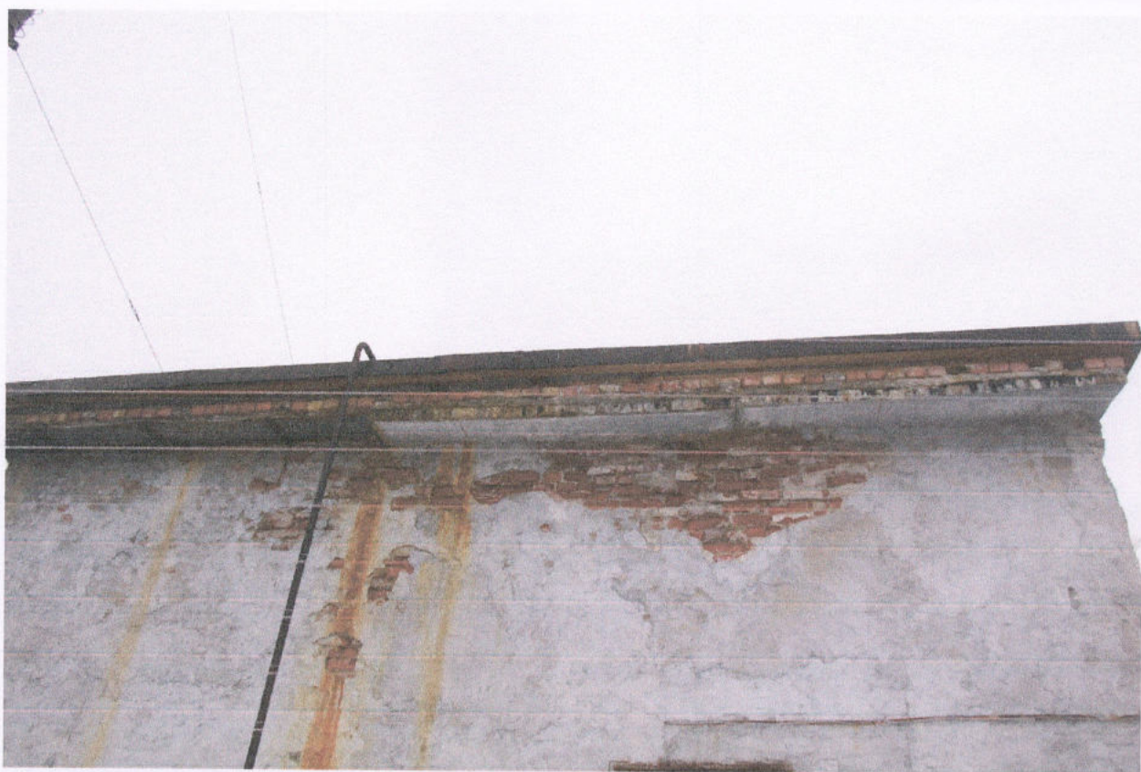
Фото 33. Разрушение штукатурного слоя и кирпичной кладки пристройки из-за неисправной ранее кровли
