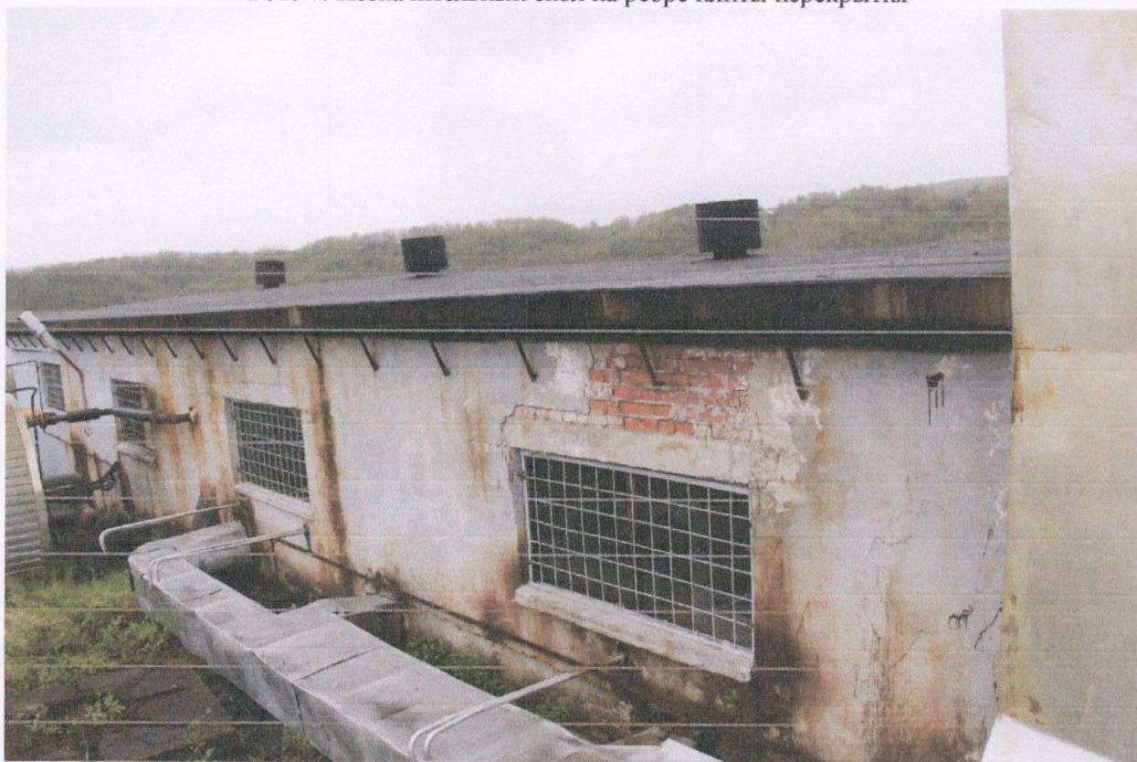
Фото 8. Разрушение кирпичной кладки наружной стены из-за протечки кровли
