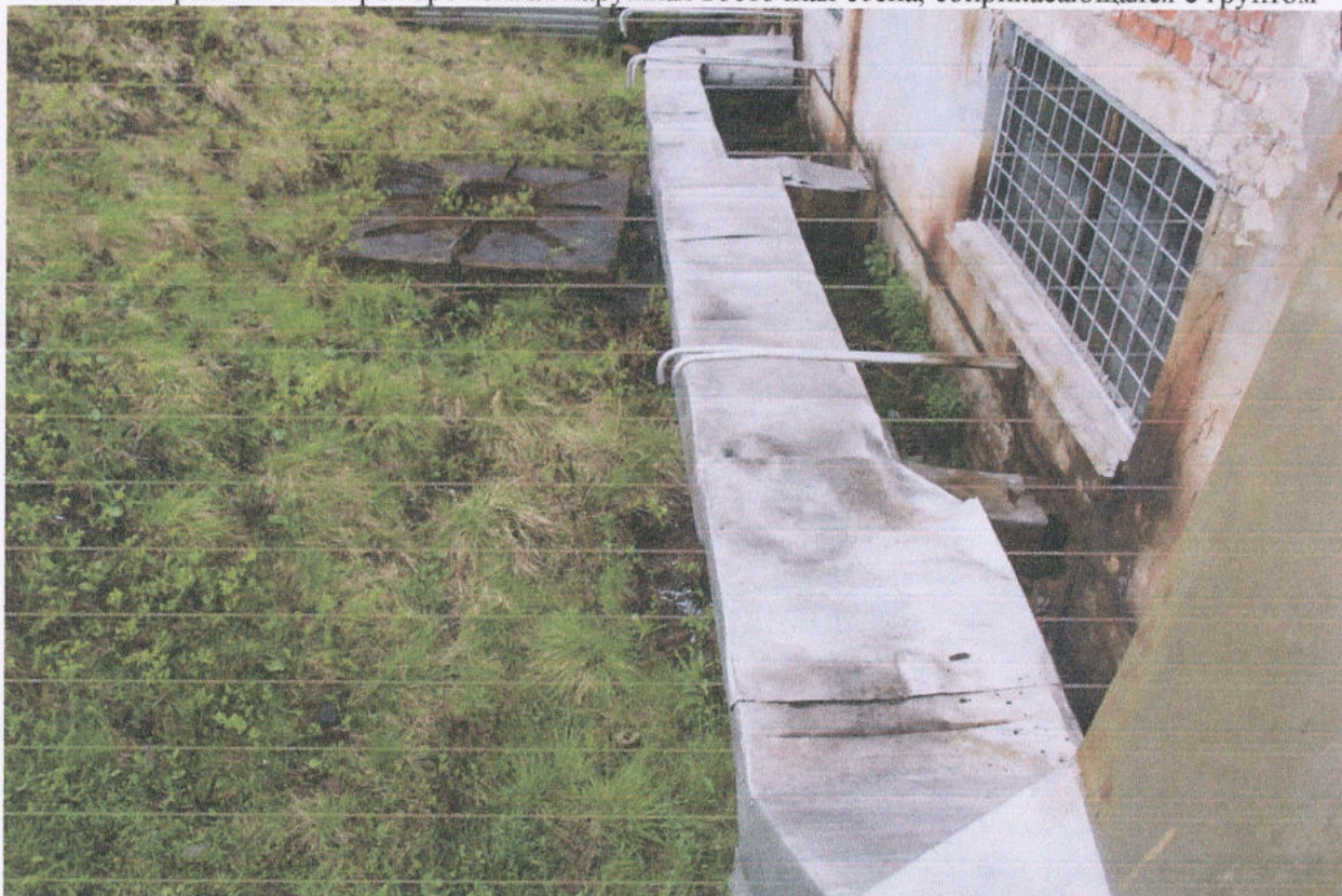
Фото 10. Отсутствие отмостки повлекло за собой разрушение наружной стены ниже уровня земли
