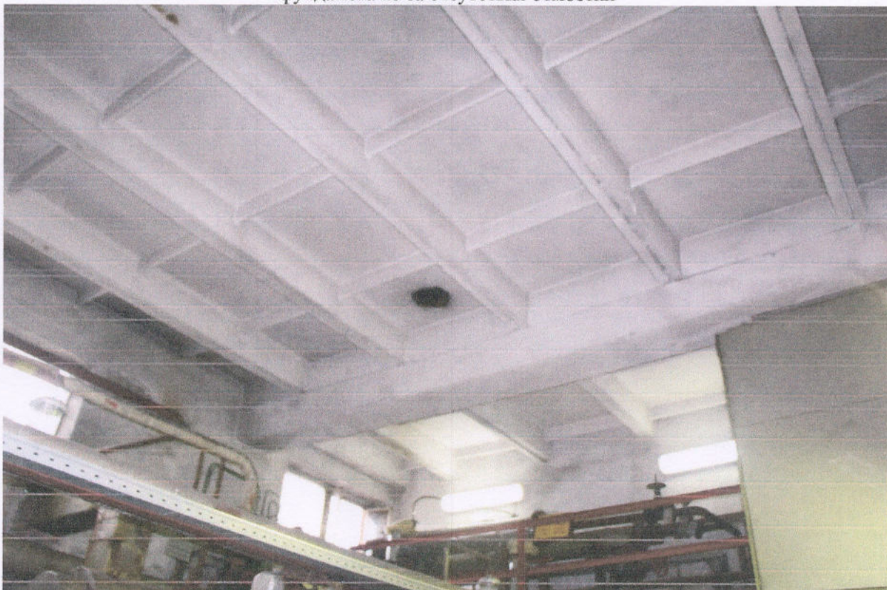
Фото 15. Ж/б перекрытие в исправном состоянии
